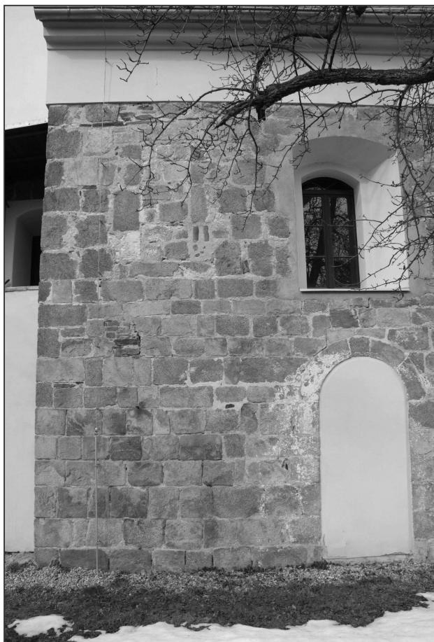
Obr. 3: Olešky (okr. Praha-východ), kostel Narození Panny Marie. Západní část jižního průčelí lodi se zazděnými románskými portály směřujícími do přízemí lodi i na pavlačovou část empory (foto M. Falta 2016).
