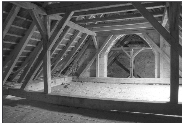
Obr. 11: Olešky (okr. Praha-východ), kostel Narození Panny Marie. Průhled krovem na východní štít lodi s vylehčujícím obloukem (foto M. Falta 2018).
