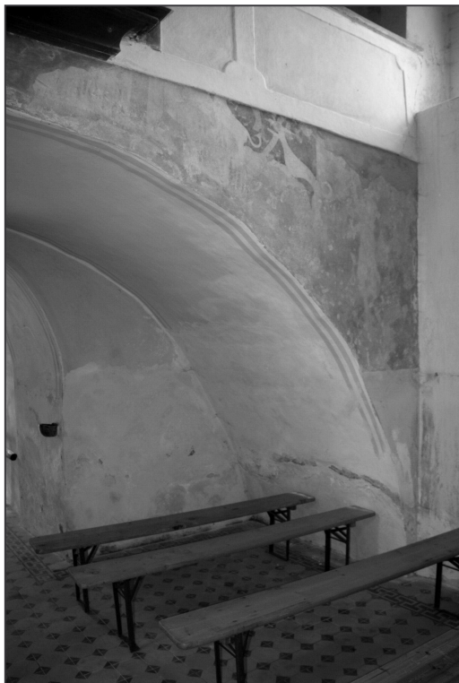
Obr. 6: Olešky (okr. Praha-východ), kostel Narození Panny Marie. Detail eliptického oblouku vynášejícího pavlačovou část tribuny (foto M. Falta 2016).
