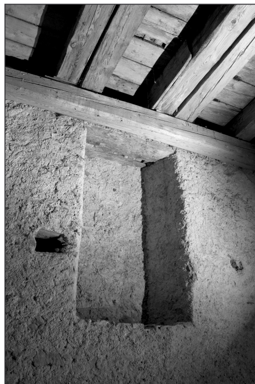
Obr. 9: Olešky (okr. Praha-východ), kostel Narození Panny Marie. Kónicky se zužující nika zastropená velkými plochými kamennými deskami coby důmyslné odlehčení necelý metr tlustých zdí ve druhém patře věže (foto M. Falta 2018).
