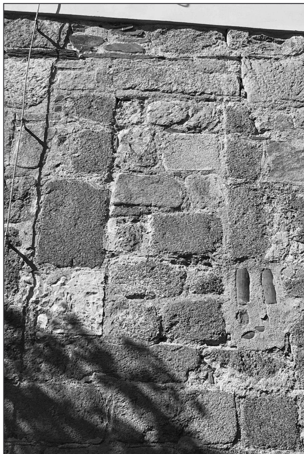
Obr. 4: Olešky (okr. Praha-východ), kostel Narození Panny Marie. Detail zazděného otvoru pravouhelného vstupu na pavlačovou část empory (foto L. Čiháková 2018).
