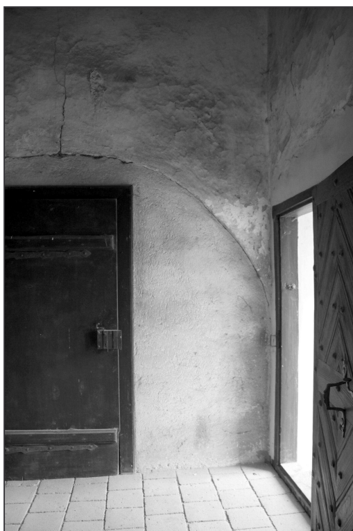
Obr. 8: Olešky (okr. Praha-východ), kostel Narození Panny Marie. Arkáda spojující věžní a pavlačovou část tribuny při pohledu z věže (foto M. Falta 2016).
